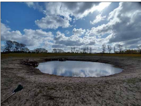
► Kleingewässer vor der Vegetationsperiode nach Abschluss der Bauarbeiten, © Katharina Brauer / WWF Deutschland
