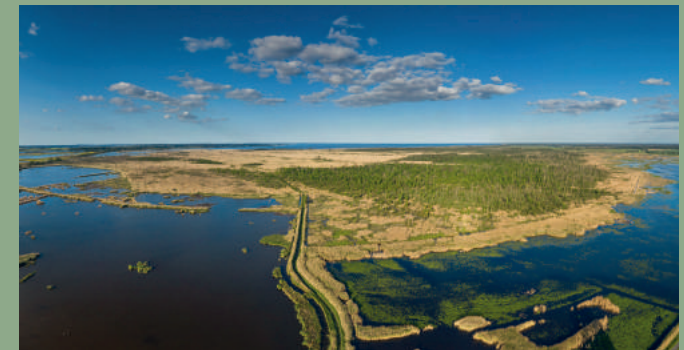
Die nach Deichbruch ertrunkene und sich regenerierende Moorlandschaft der Peenemündung, Mecklenburg-Vorpommern, Foto: T. Dahms
